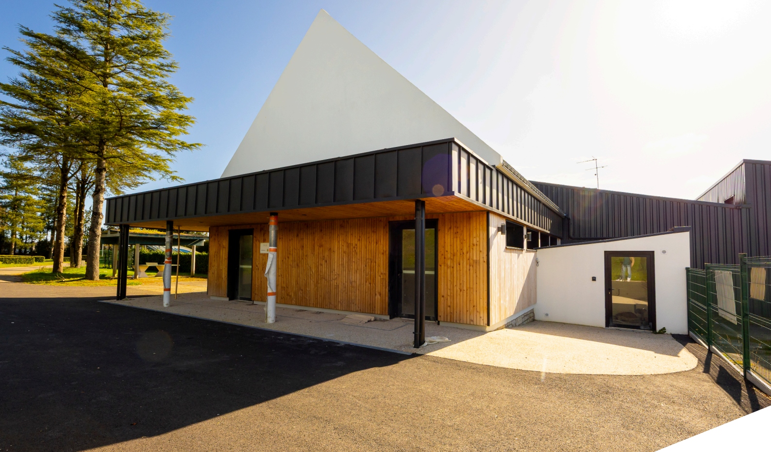
Futur bâtiment sanitaire au camping municipal
